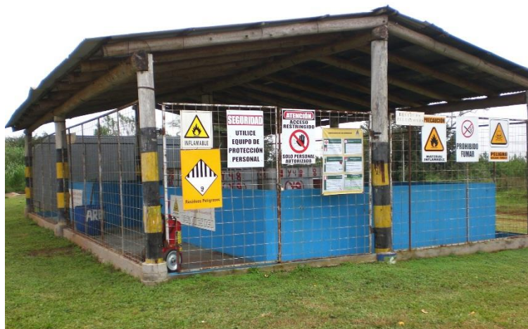
Figura 5: Centro de acopio de envases vacíos de agroquímicos.
